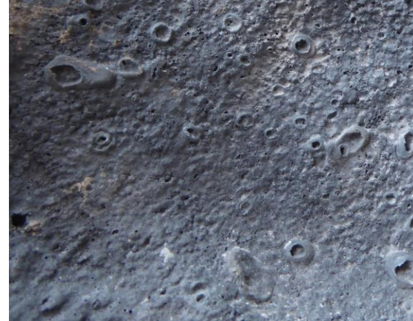
Oberfläche eines porösen Spülers nach Ausbau
